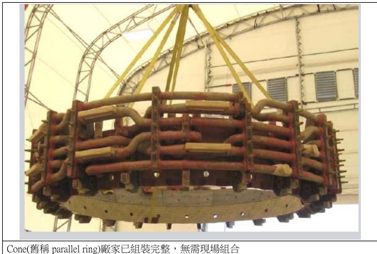
圖例 MOD 5 錐形環安裝 Cone Installation
