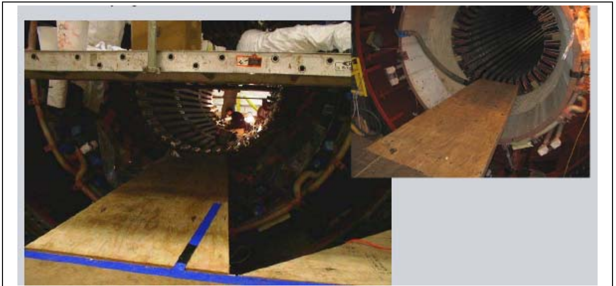
在 gen 與 exciter 間搭建通道(便橋)，以搬運線圈
