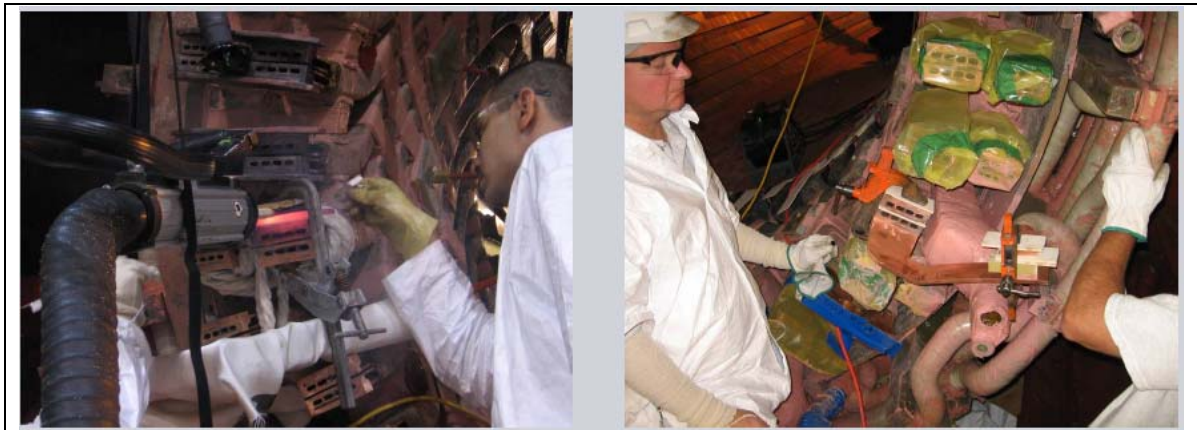
圖例 MOD 8 線圈連接及絕緣
