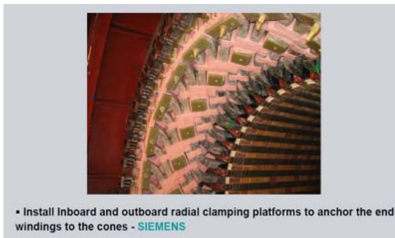
圖例 MOD 9 牢固線圈末端
