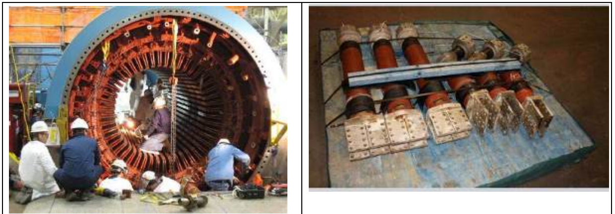
西門子負責拆除與檢查 main leads，核一廠負責搬運與存放保管
