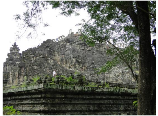
巴本宮側牆面並非平面，修復時利用電腦科學三維拼圖完成曲面原狀
