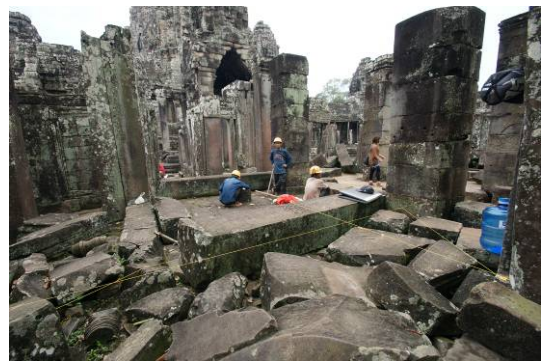
巴戎廟修復現場正在丈量的場景
