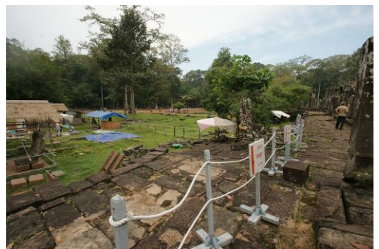
修復工地以繩子做的簡易圍籬，和臺灣鋼浪板等施工圍籬不同
