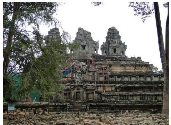
塔凱歐寺修復現況，目前禁止外人進入
