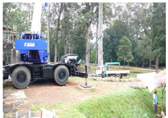
現場以大型吊車將石雕文物吊起方便 定位修復
