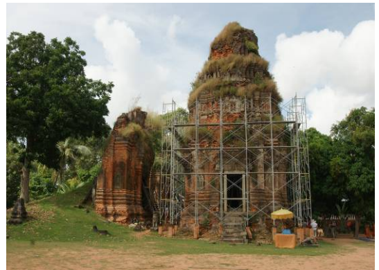
羅蕾寺外圍架設假設工程進行修復中
