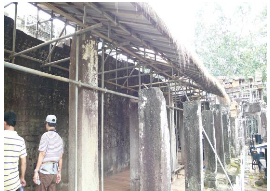
日本以簡單的頂棚架保護浮雕牆並方便施工修復
