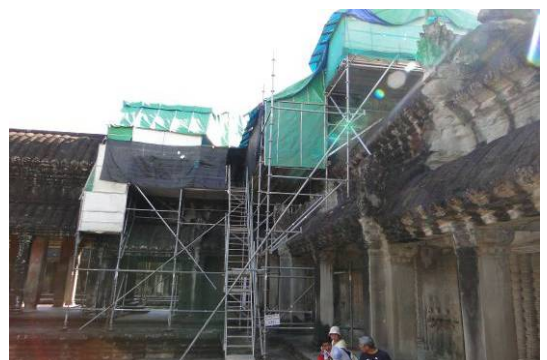
德國修復小吳哥中門塔頂的假設工程
