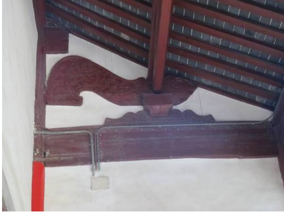
電線穿入金屬管
