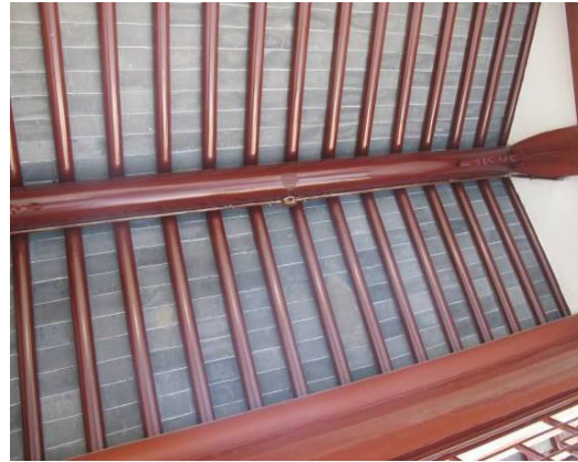
電線穿入金屬管
