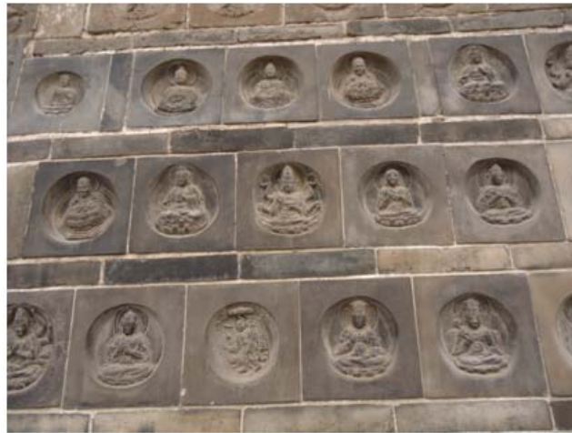
【繁塔外壁用不同的加釉灰色方磚砌成鑲嵌佛像】
