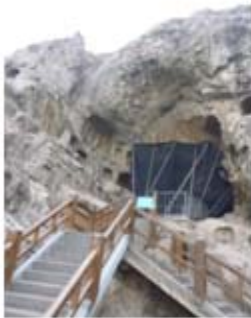
【蓮花洞正在整修封閉】
