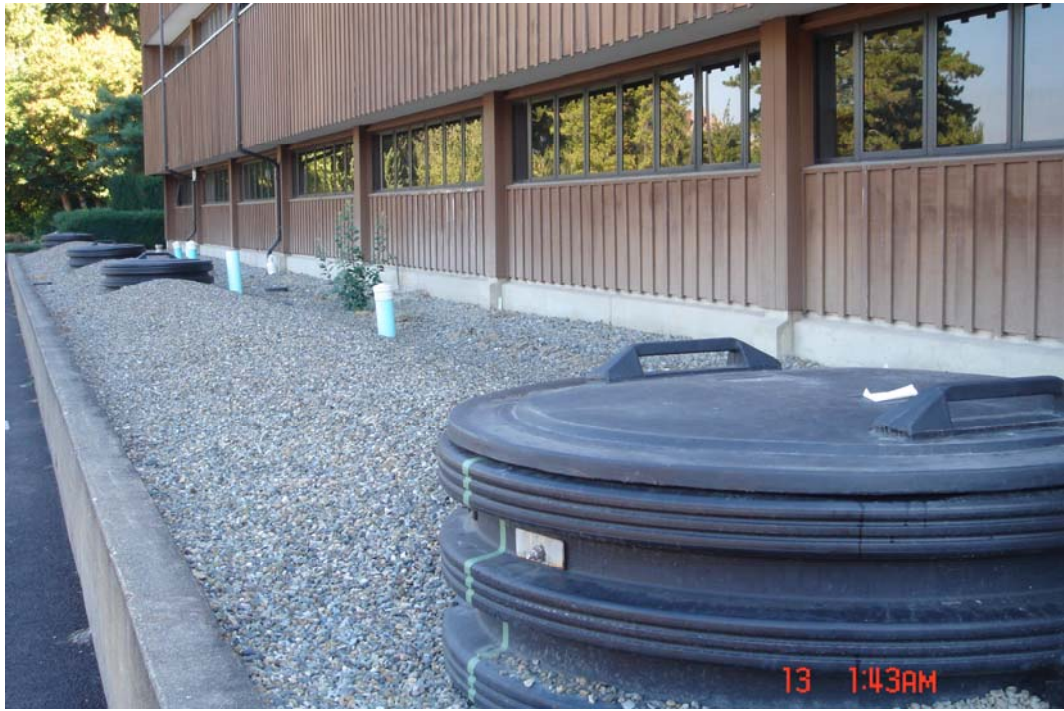
圖 41 Puyallup 研究推廣中心雨水收集系統（1）
