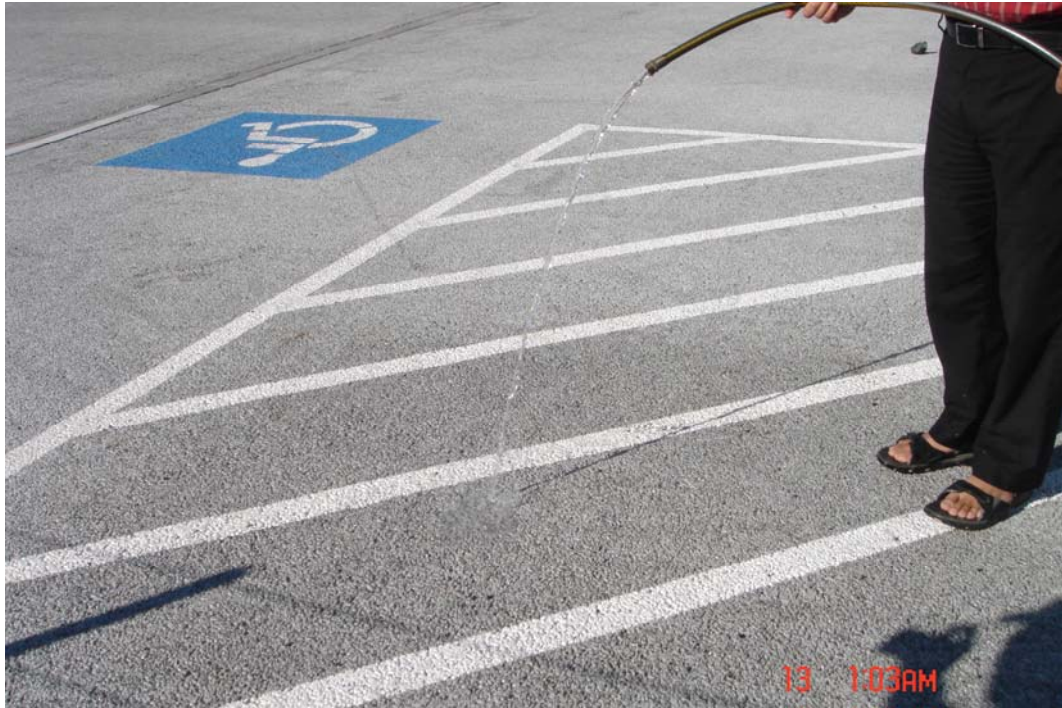
圖 34 Puyallup 研究推廣中心停車場透水混凝土試驗
