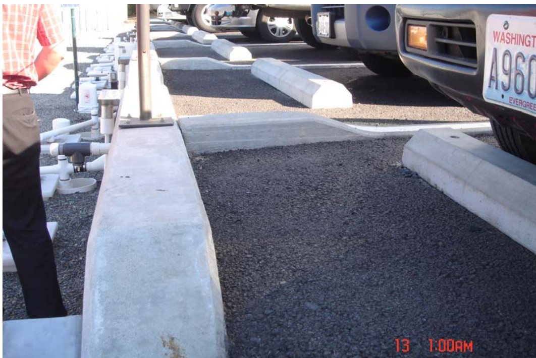
圖 35 Puyallup 研究推廣中心停車場透水瀝青試驗
