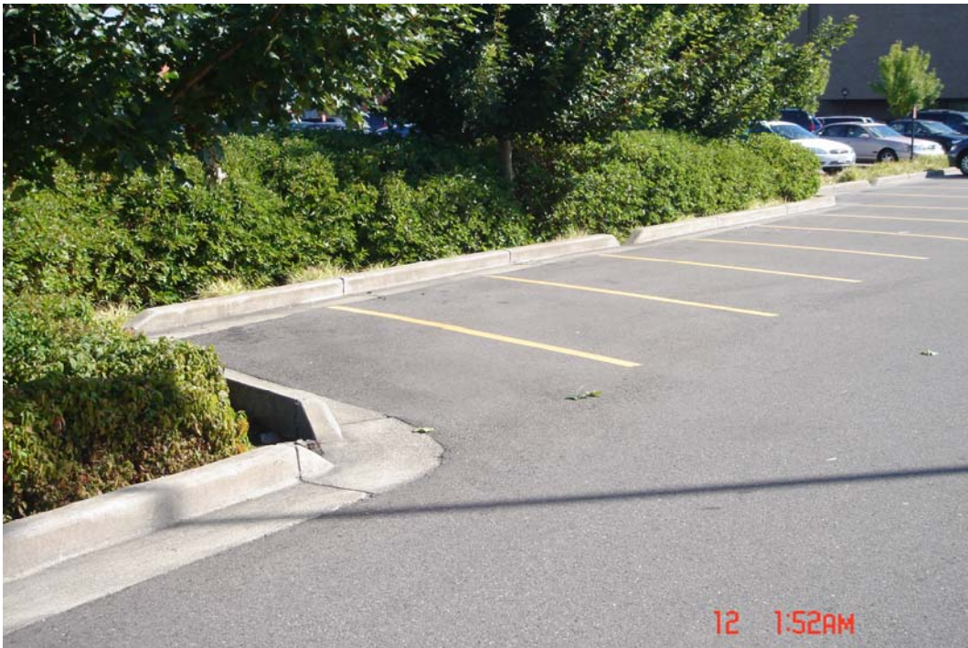
圖10 Northgate Mall生態滯留池系統
