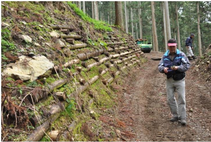
圖十、以間伐木為護坡結構之生態材料
