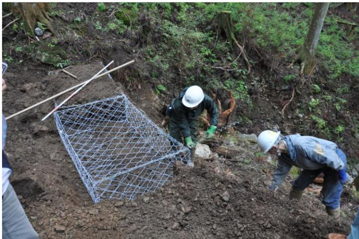
圖十一、利用簡易組合的石籠鐵絲網護溝操作方便效率高
