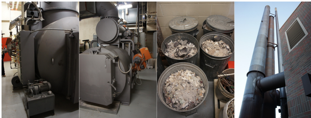
圖十四、A 及 B 為大小焚化爐共 2 座；C 為焚化爐清除底灰；D 為空氣排放煙囪，BSL-3 級實驗室排放煙囪較其他實驗室高，以維持負壓狀態。
