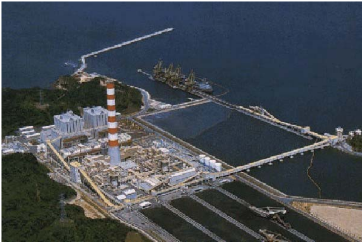
照片 10 J-Power 松島電廠煙囪俯視 ( http://www.jpower.co.jp )
