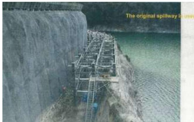
圖4-7-28 施工棧道利用舊有排洪導流溝架設之現況
