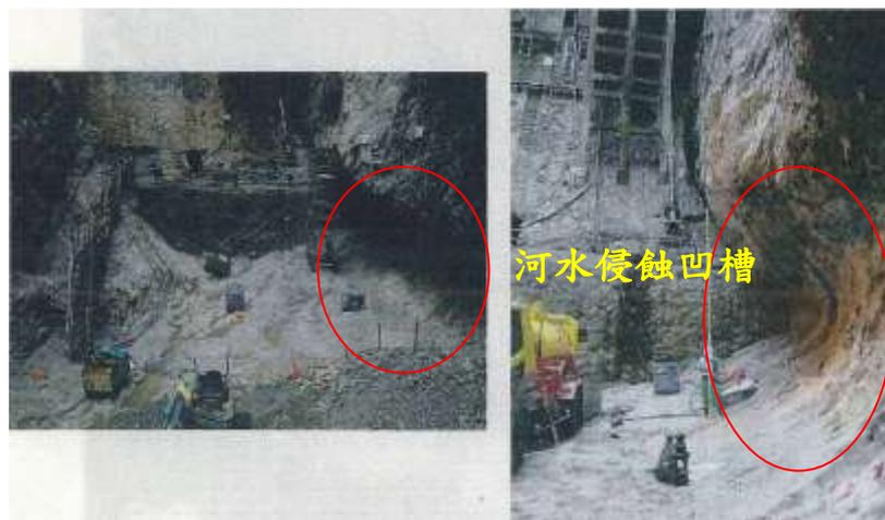
圖4-7-35 壩下游石灰岩地層因河水侵蝕造成凹槽
