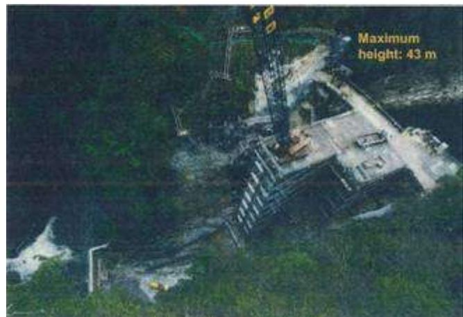
圖4-7-31 壩體下游側上方架設施工平台之示意圖及現況
