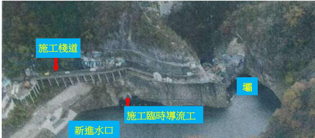
圖4-7-24 施工臨時設施布置現況
