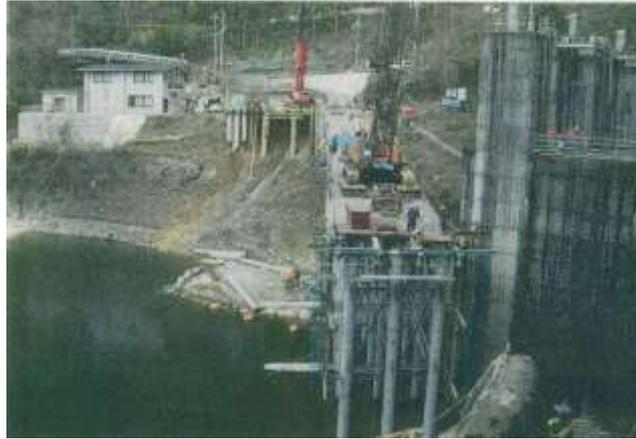
圖4-7-30 施工棧道採斜張式架設工法之現況
