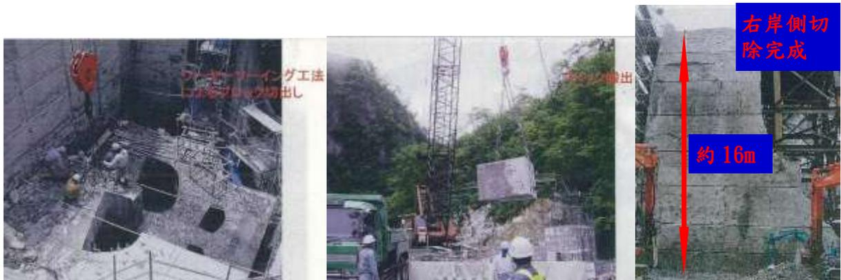
圖4-7-37 舊壩體採線鋸切割工法切除及吊車吊運
