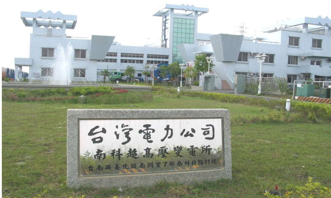
圖 2 台南園區南科超高壓變電所
