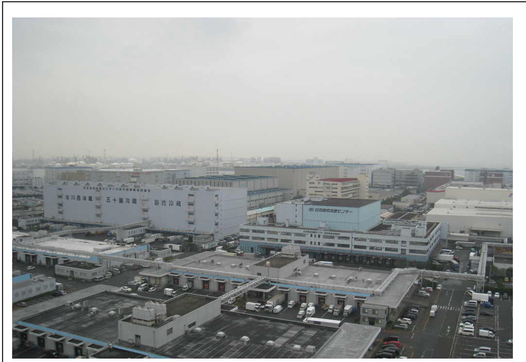
圖 7 日本食肉流通中心冷蔵庫、肉品處理室，裝卸貨位
