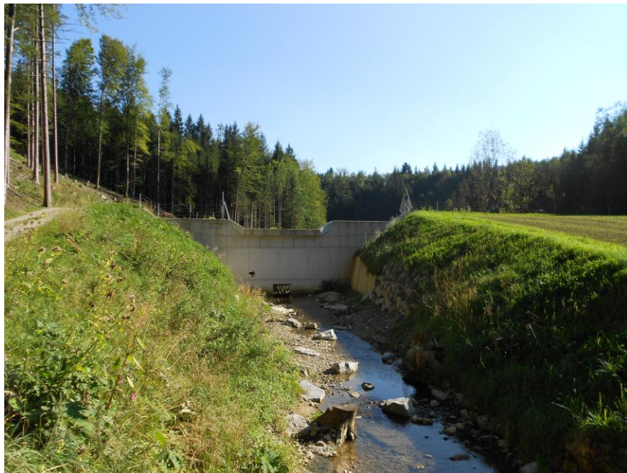
圖 10 Pillsteinbach 高地滯洪池(下游面)
