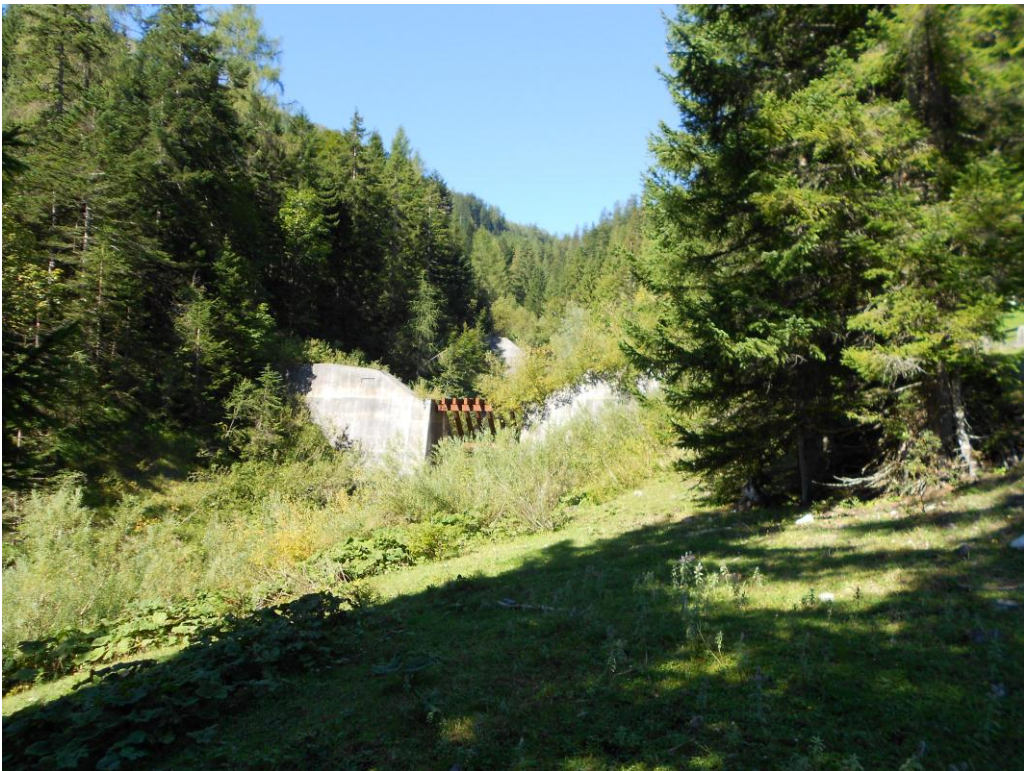
圖 12 Karbach 野溪梳子壩
