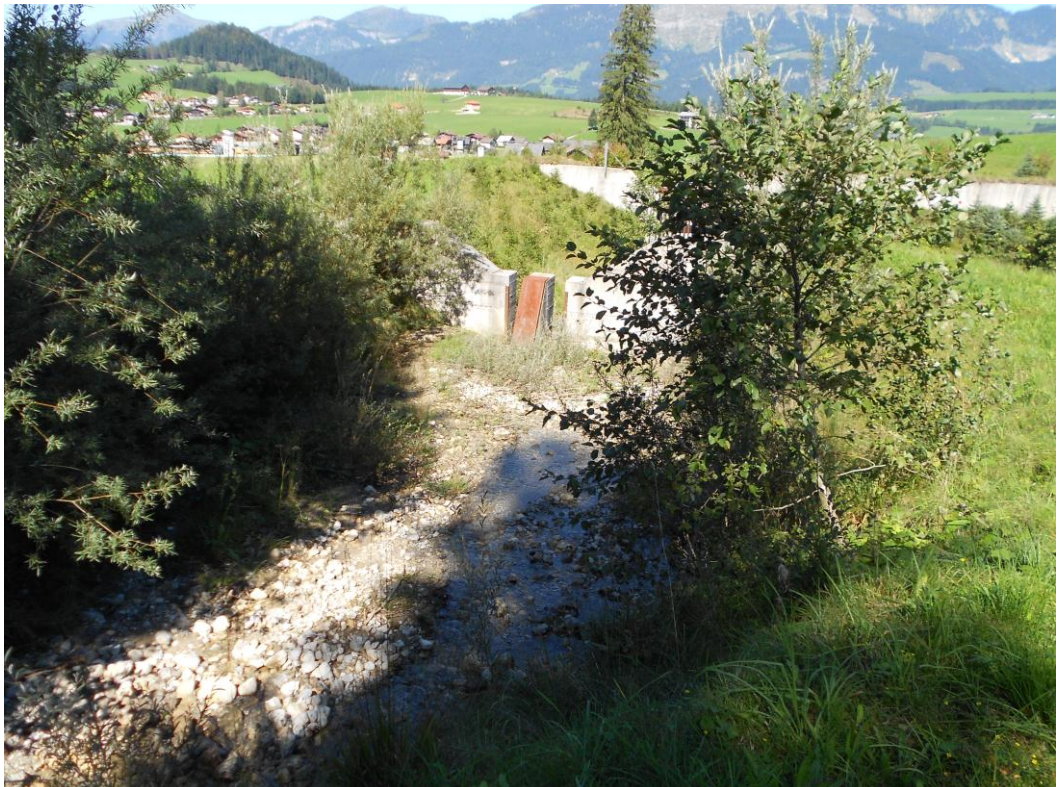
圖 6 Abtenau 地區 Abtenauerbach 野溪防砂壩
