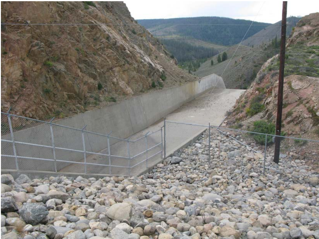
Granby 壩溢洪道
