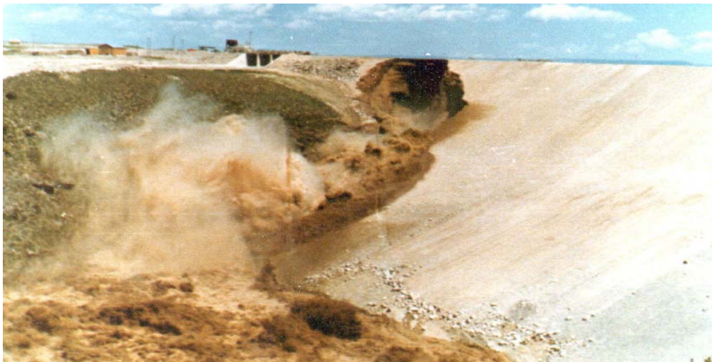
Teton 壩破壞程度持續擴大
