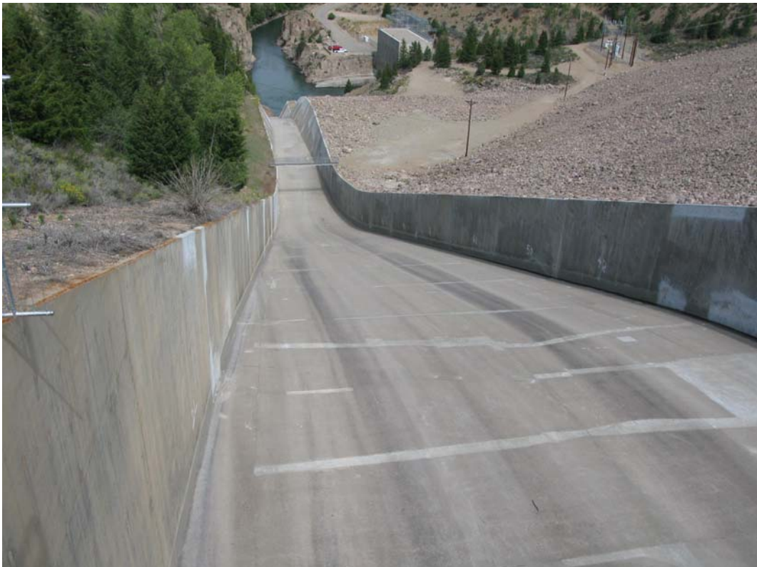
Green Mountain 溢洪道、靜水池及發電廠
