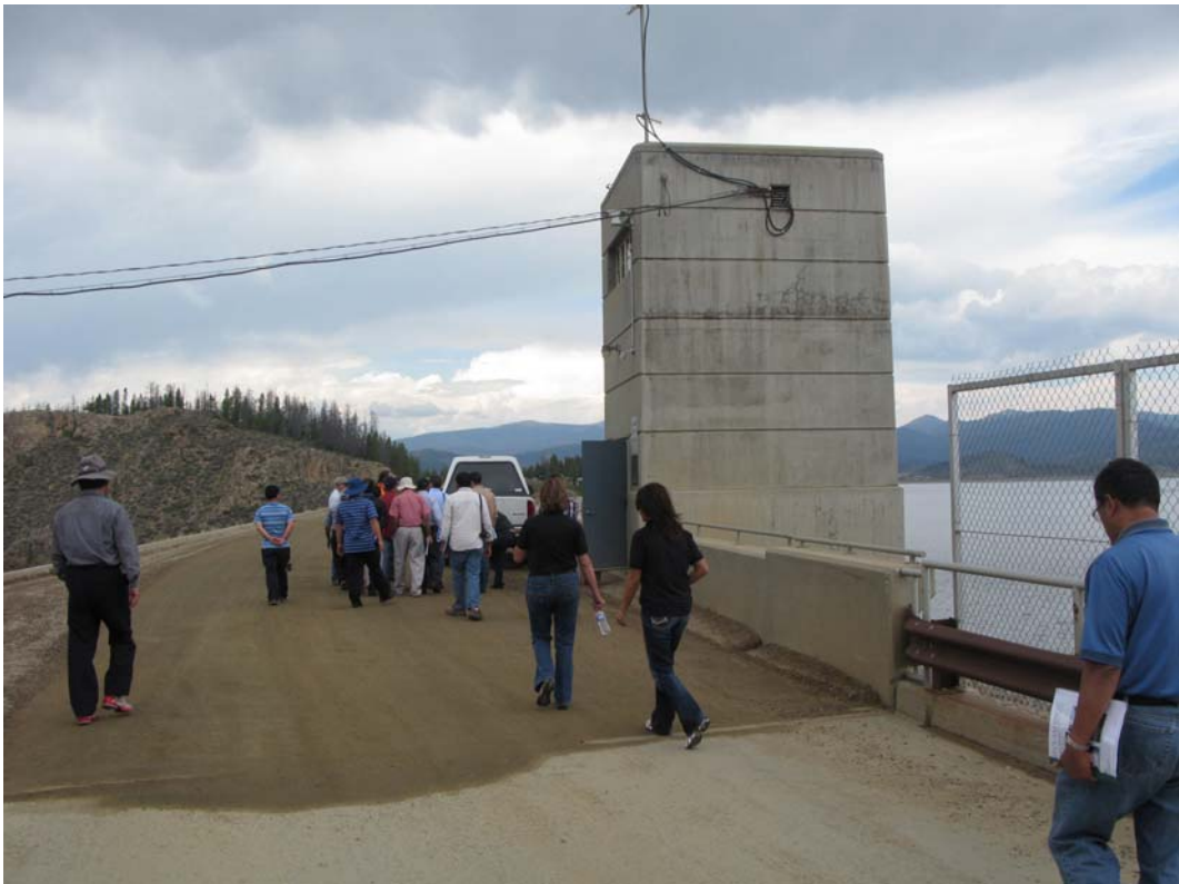
Granby 壩豎井電梯直通 70 公尺下之取出水工閘室
