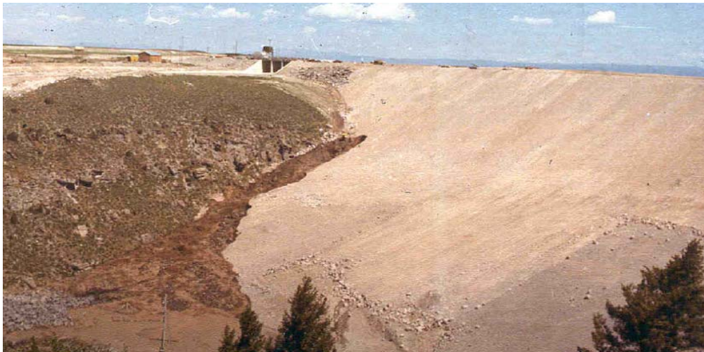
Teton 壩初期管湧情形
