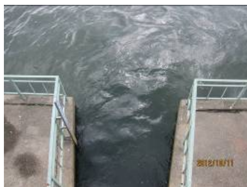
圖 41 霞浦污水廠放流水出口情形
