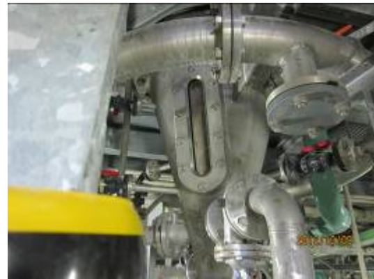
圖 8-2 MAP 結晶反應塔底部設施
