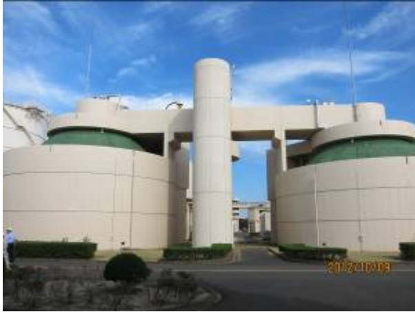
圖 6 西部污水處理廠污泥消化槽
