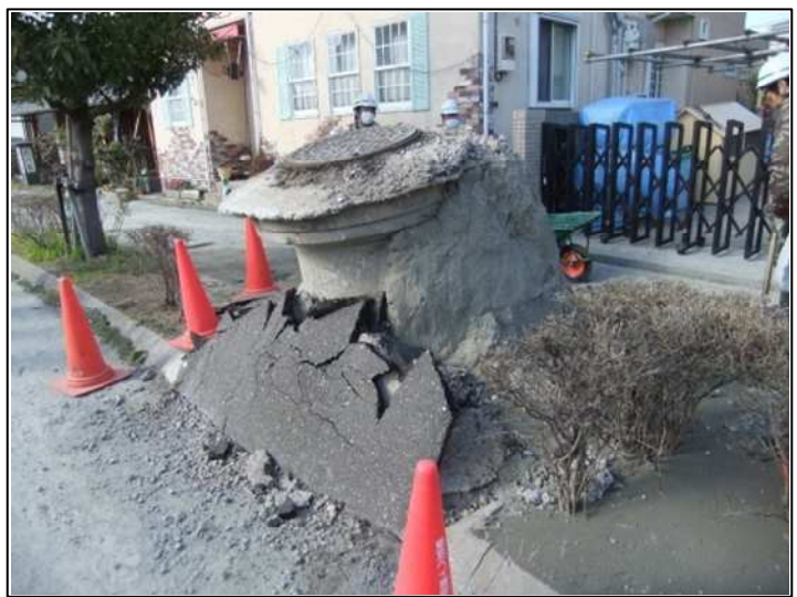
圖 8、東日本地震後 Minami-gamo 處理廠損毀及路面人孔上浮情形
