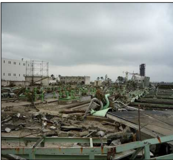
圖 8、東日本地震後 Minami-gamo 處理廠損毀及路面人孔上浮情形
