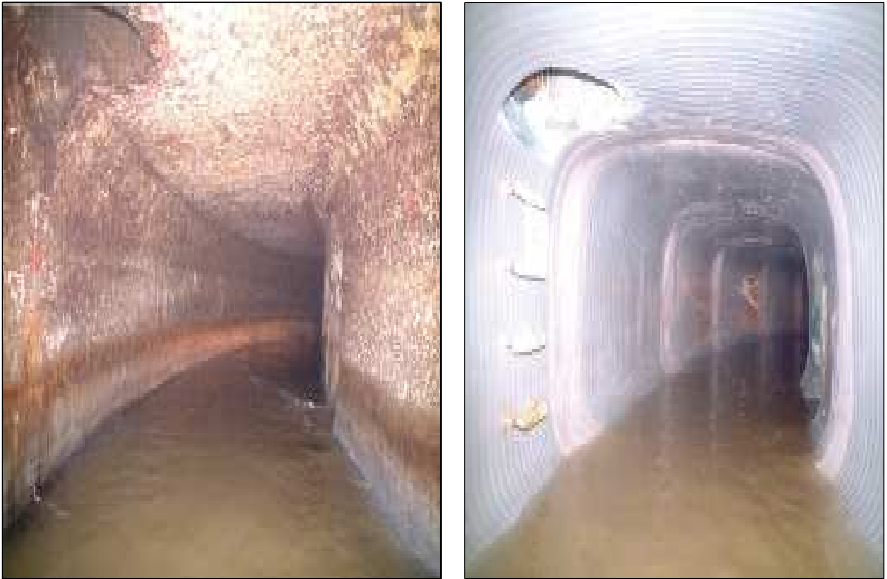
圖 9、利用反轉工法更新下水道管線前後對照
