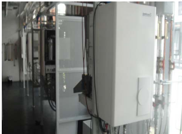
圖 27 冷凍機、熱鍋爐安裝維修訓練
