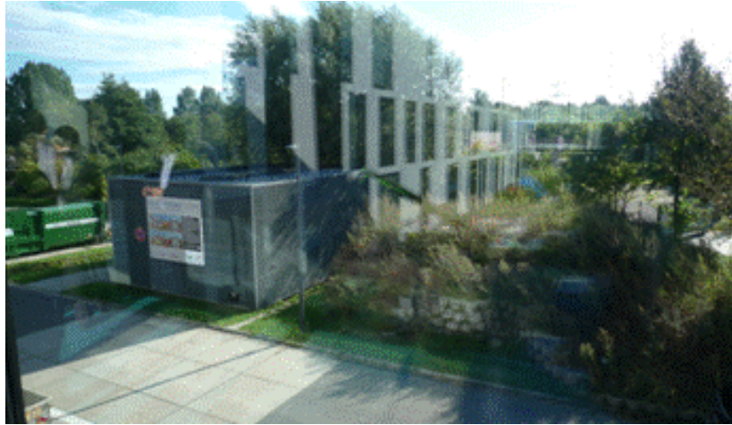
圖 33 跨季儲冷儲熱設施
