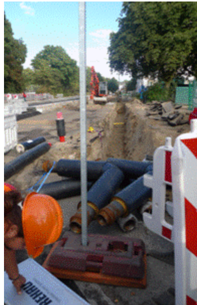
圖 44 能源之堡供能管線施工照片
