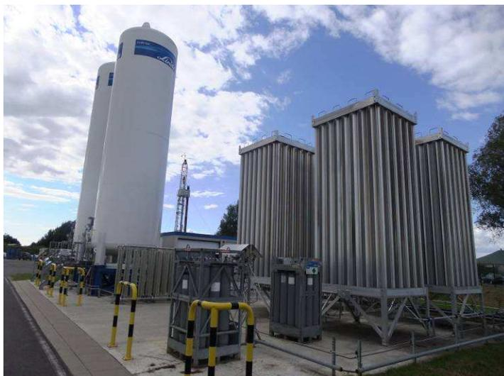
圖 8、Ketzin CO<sub>2</sub> 注入場址(氣體儲槽)
