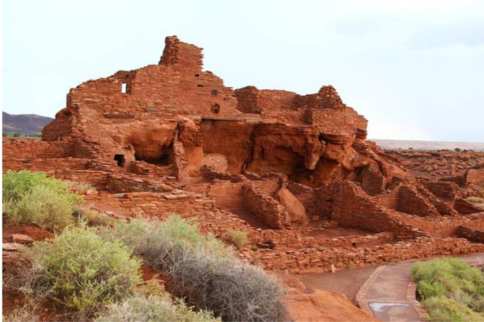
1930~60 年代，用水泥整修牆面，後來改用較新的膠泥，較接近原始材料，雖然它破壞了歷史建築，但也使這建物經得起自然和人為的腐蝕。為了保存而改變這一建築，例如原本地板較低，但為了維持地板特徵並使牆不會倒下，而將沙土放進屋內。另外也做了一些現代的排水裝置以防止水積在屋中。
