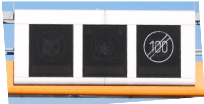
可變式解除速限標誌
