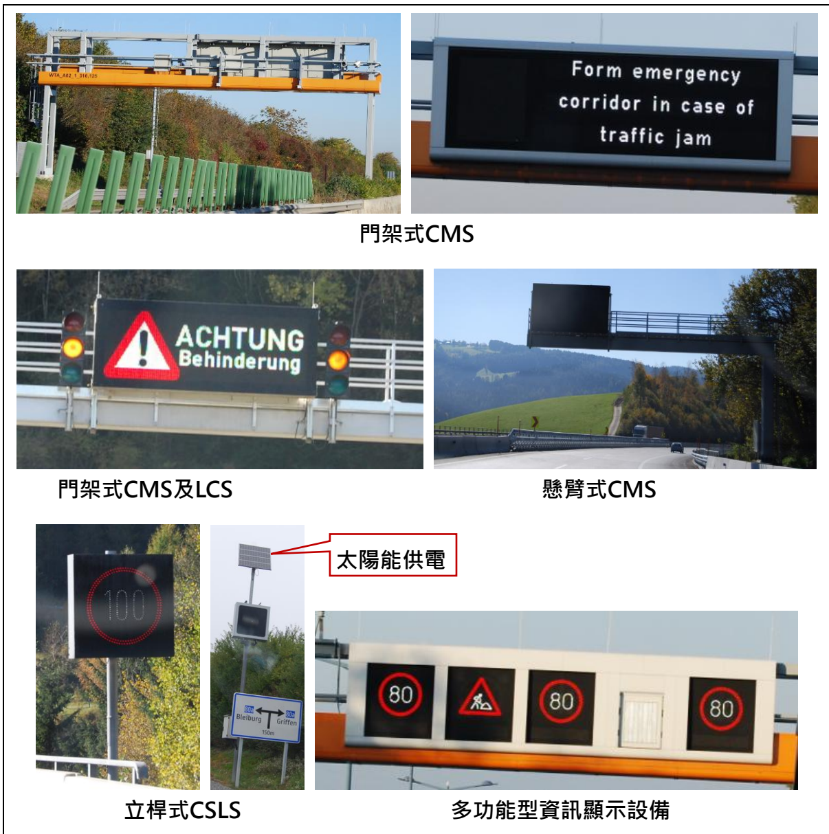
圖3. 2. 16資訊顯示及交通管制設備考察照片
