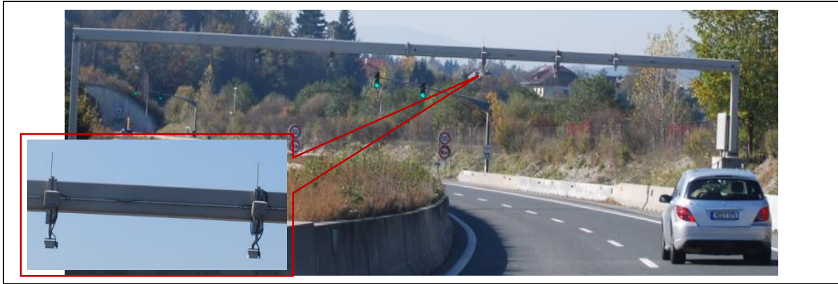
圖3.2.17交通資料收集設備考察照片
