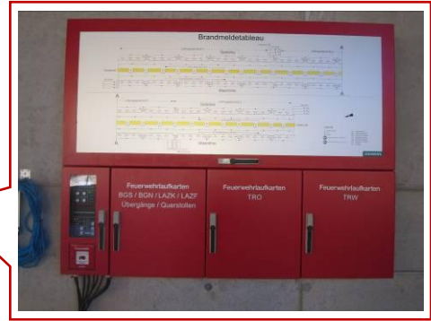
火警系統偵測顯示盤
