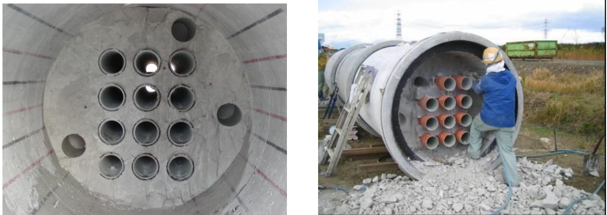
圖 8 TC-Grout 材料充填測試，充填性良好，推管上方空隙很小， < 1\text{ cm}
