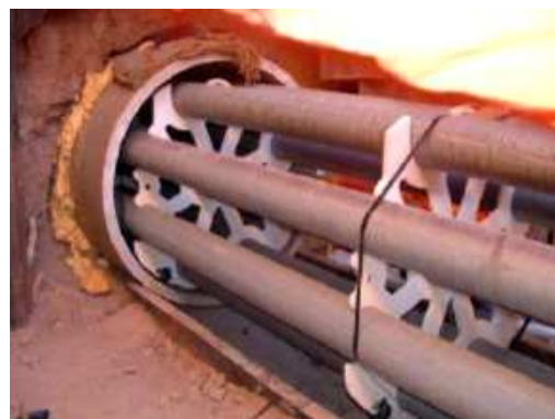
圖 11：鑽管管線配置及隔版
