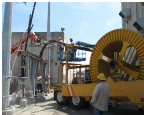
圖 15：專用車軸架施工
