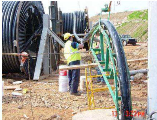
圖 3：電纜施工延放情形
