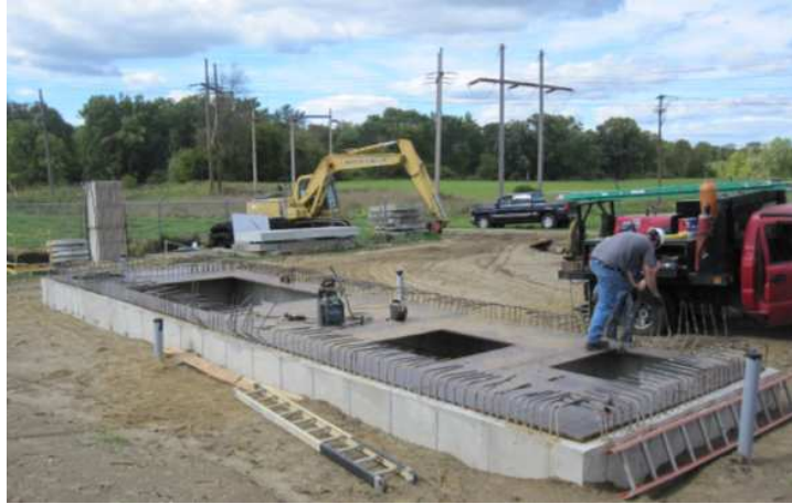
圖 7： 實際施作試驗人孔及設備模擬現場作業評估
