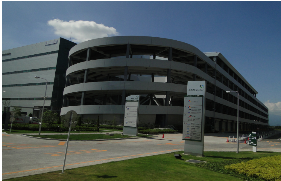
圖7 物流中心的立體車道
