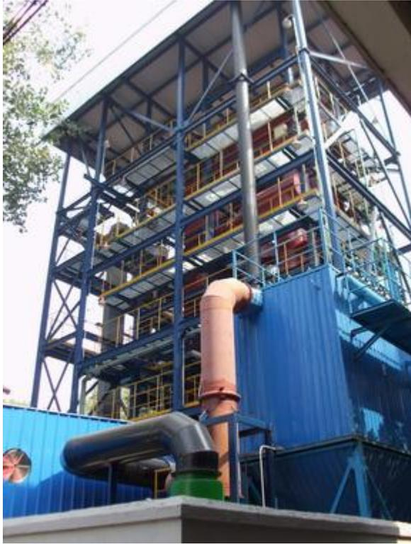
圖 III.2-15 3 MW 富氧燃燒 CFB 試驗平台全景
