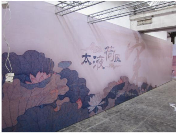
左圖 4：桁架搭設與電線佈線
