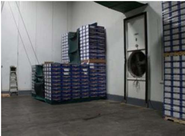
圖 54.轉色完後利用壓差預冷快速降低溫度
