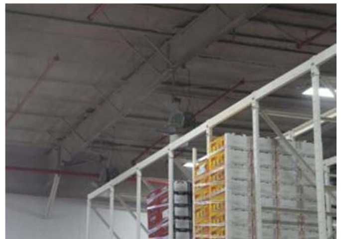
圖 52,53.及時品質監測與轉色後熟庫內以風扇配合霧化機提高濕度
