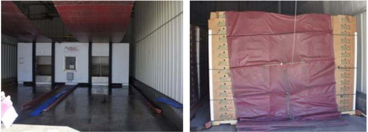
圖 19,20. 強制風冷處理設備與園產品實際處理情形，另注意於產品包裝箱上應有開口以利冷空氣進入箱內（拍攝於 Ocean Mist company）
