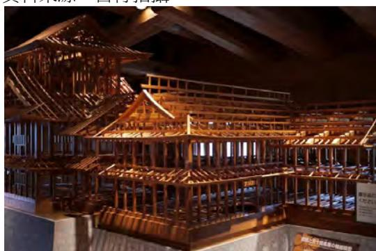
圖 93 80 金澤城內卯接工法復元模擬
