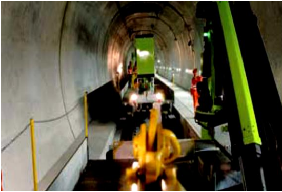
圖134.隧道維護作業
