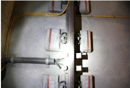
圖126. Level 2道旁計軸器
