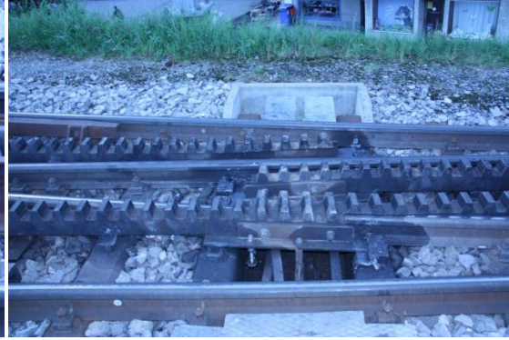
圖193.格林瓦德站Strub齒軌
