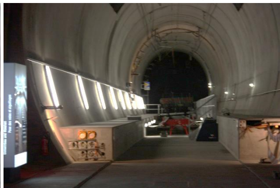
圖110.目前施工中的西隧道
