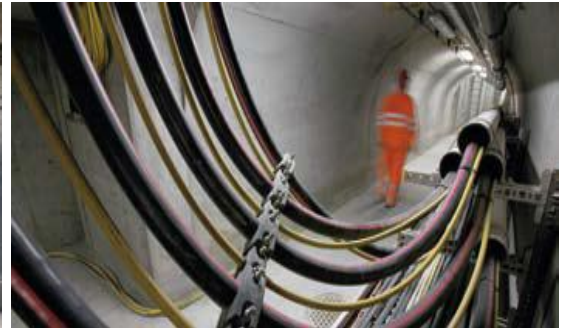
圖131. 隧道管路檢查
