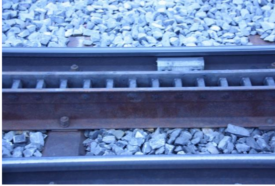
圖192.格林瓦德站Riggerbach齒軌
