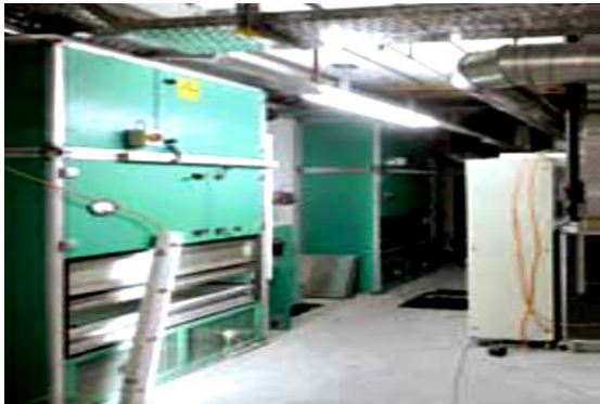
圖137.隧道空氣供應中心
