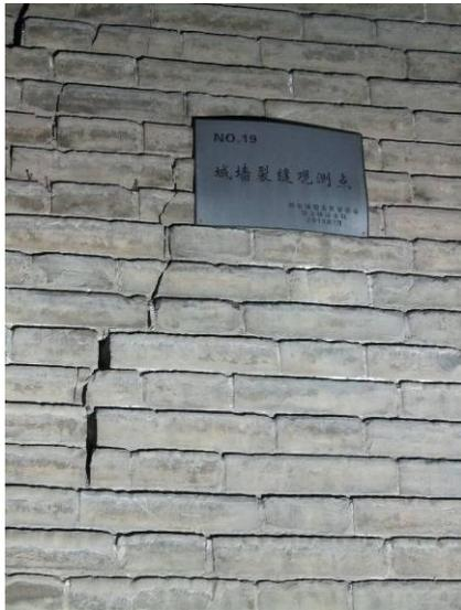
圖 25：西安城牆景區管理會設置「城牆裂縫觀測點」監測損壞情形
