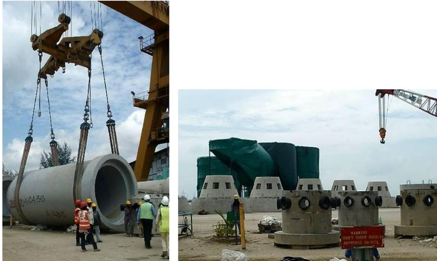
圖 3.7-3 樟宜水處理回收廠海放管、海放管散流口與散流口保護套頭施工過程
