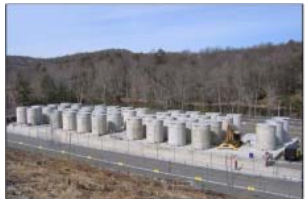
圖 NAC 公司乾儲設施: 垂直站立之金屬容器(Canister)外加水泥屏蔽(Cask)
