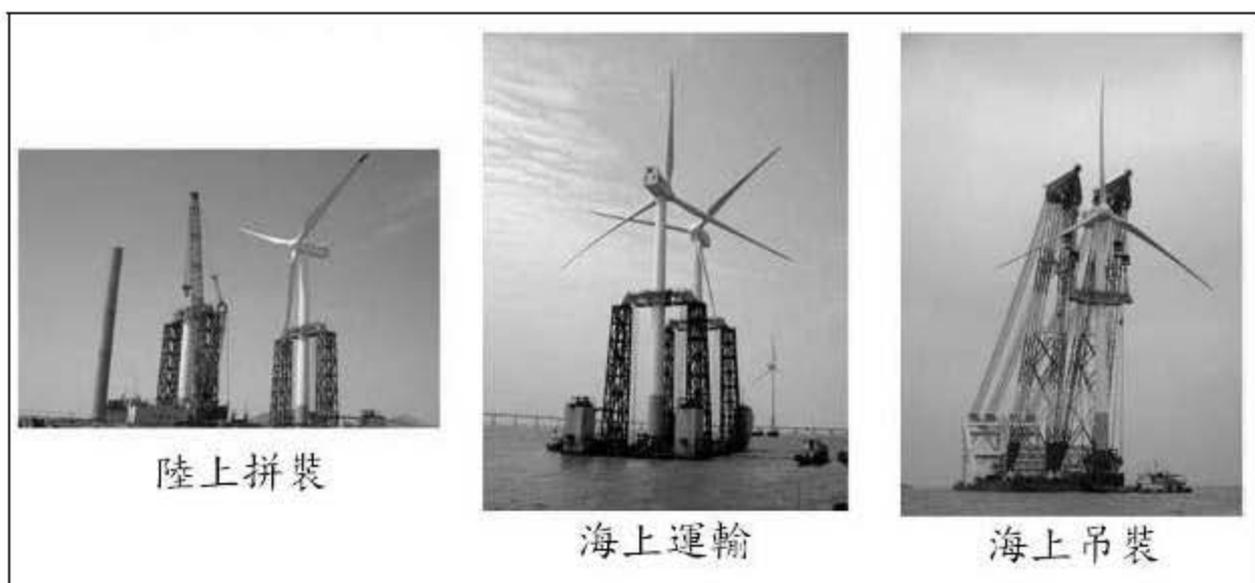
圖43：陸上拼裝→海上整體運輸→海上整體吊裝
