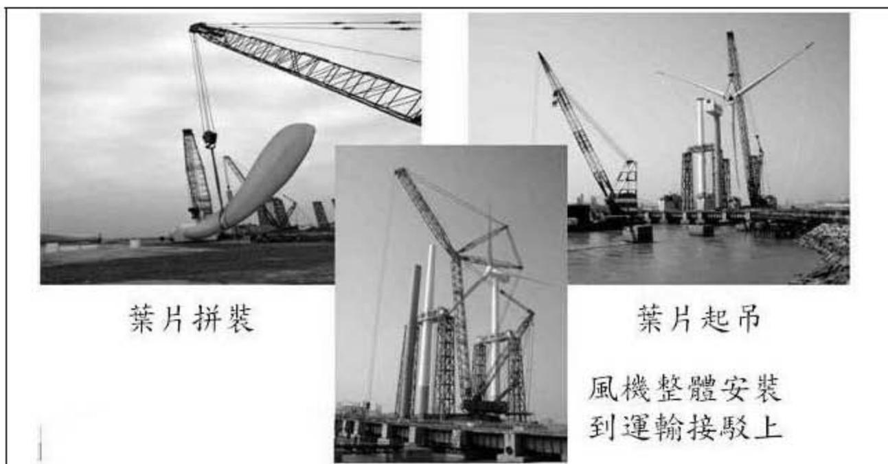
圖44：風機整體安裝到運輸接駁上
