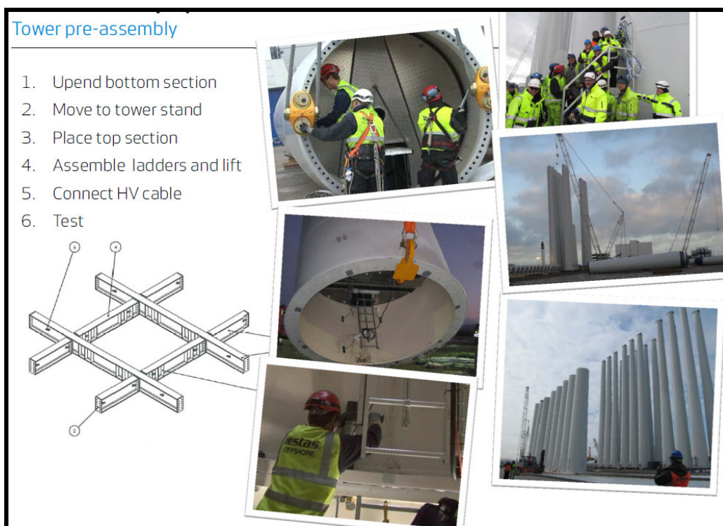
圖 7-6-1：塔架預組裝作業
