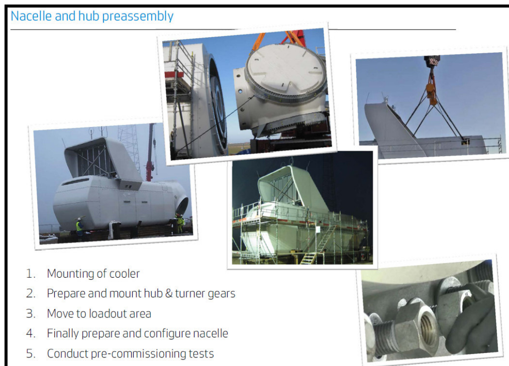
圖 7-6-3：機艙及轉子預組裝作業
