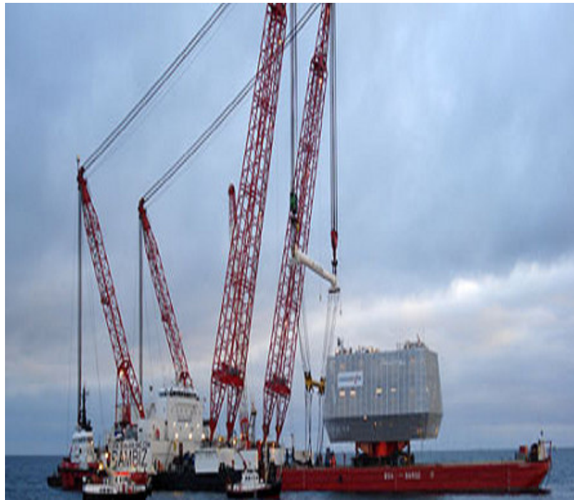
圖 6-3-1 海上變電站吊裝
