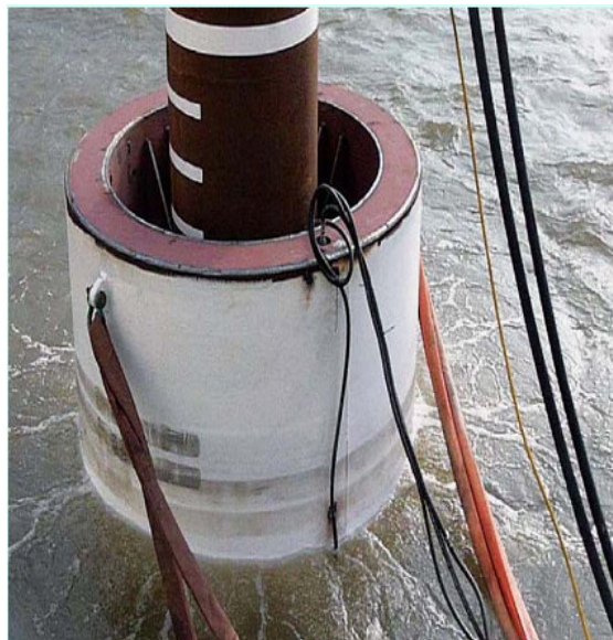
圖9-3-1 樁頭加緩衝墊及消音罩以減低施工噪音
