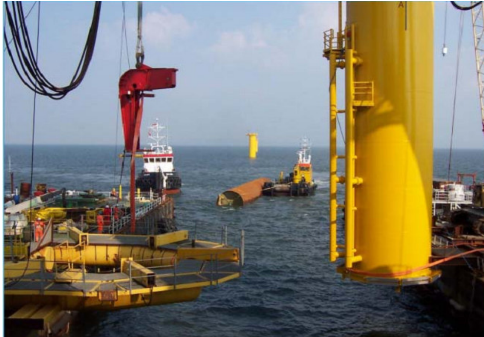
圖9-4-1 漂浮式單樁運送方式
