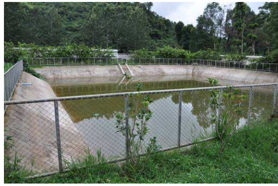
照片 63 停用水力發電渦輪機下方靜水池改作灌溉用農塘兼作滯洪池
