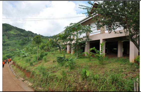
照片 48 避免大量挖填邊坡所構建試驗站建物
