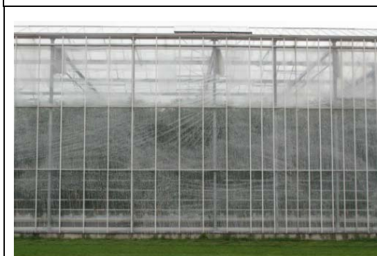
圖 7C. 塗料增加散射光，冬季可清除
