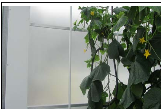
圖 7A. WUR 研發具散射光線之披覆材料
