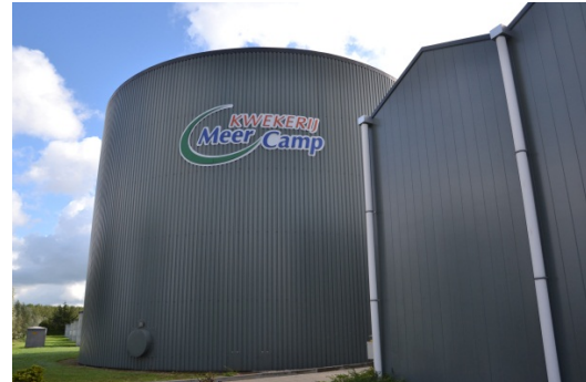
圖 73A.自有電熱共生設備-1
