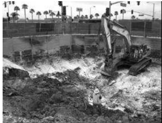
(B) 開挖地區噴灑除味藥劑
