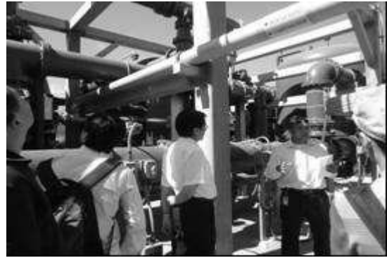
(B) Santa Monica Water Treatment Plant 管理人員講解現況
