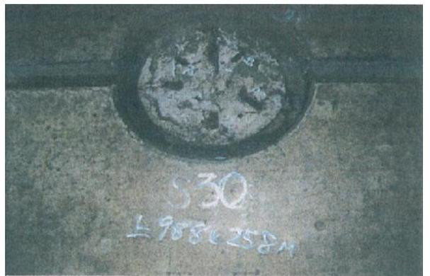
圖 4-9 防動塊發生缺損
