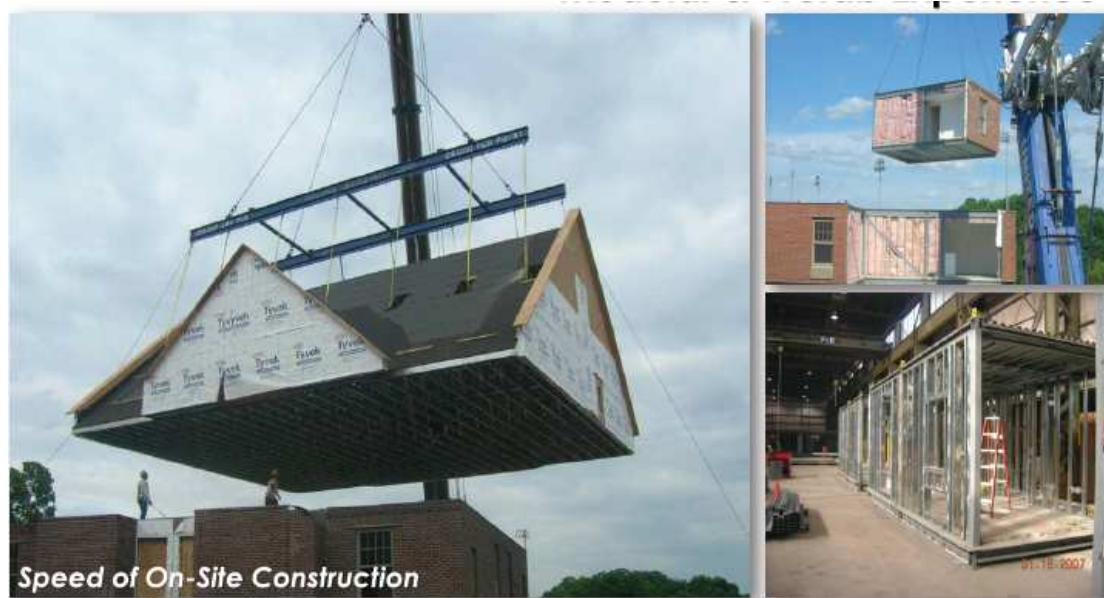
圖 8、模組化施工一例
