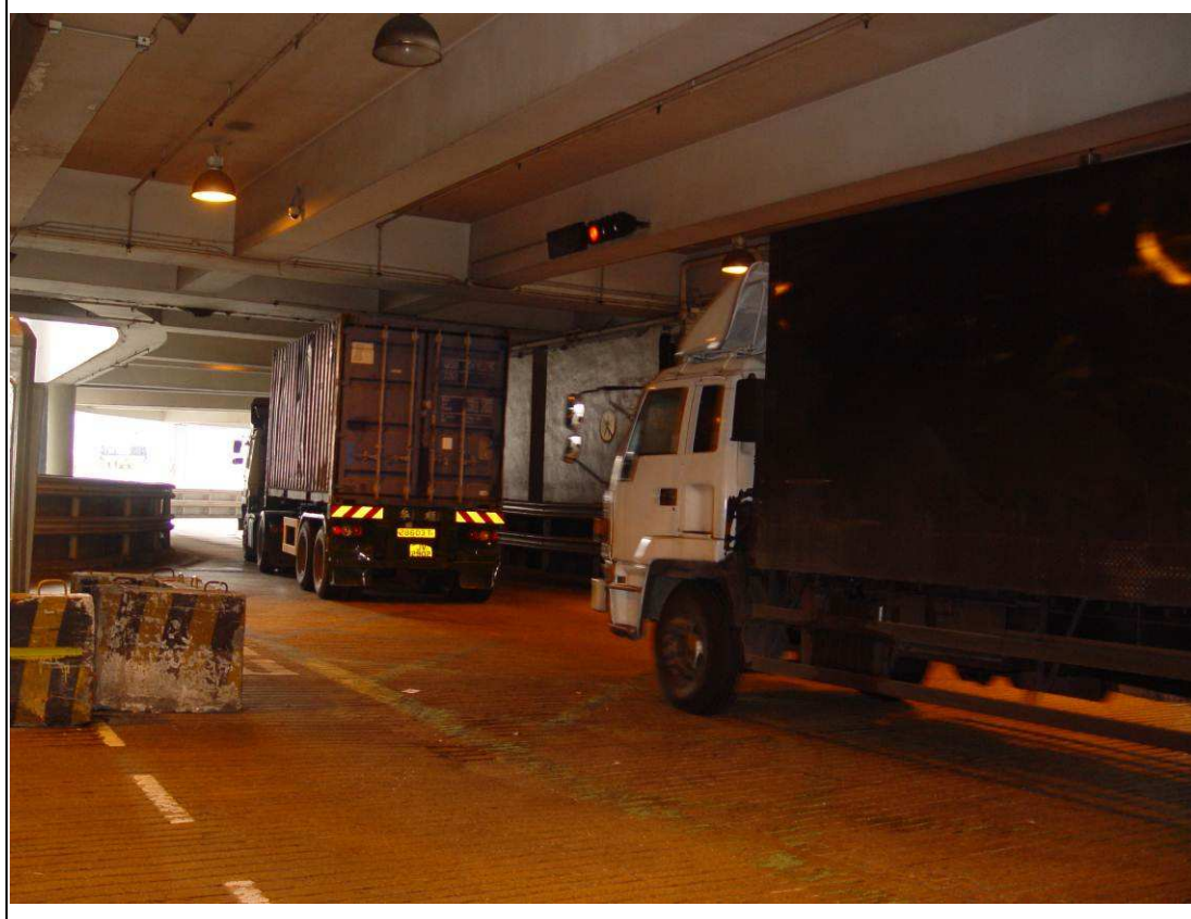
圖 6： 貨櫃車動線採雙向車道，迴轉道則增大，以便作業
