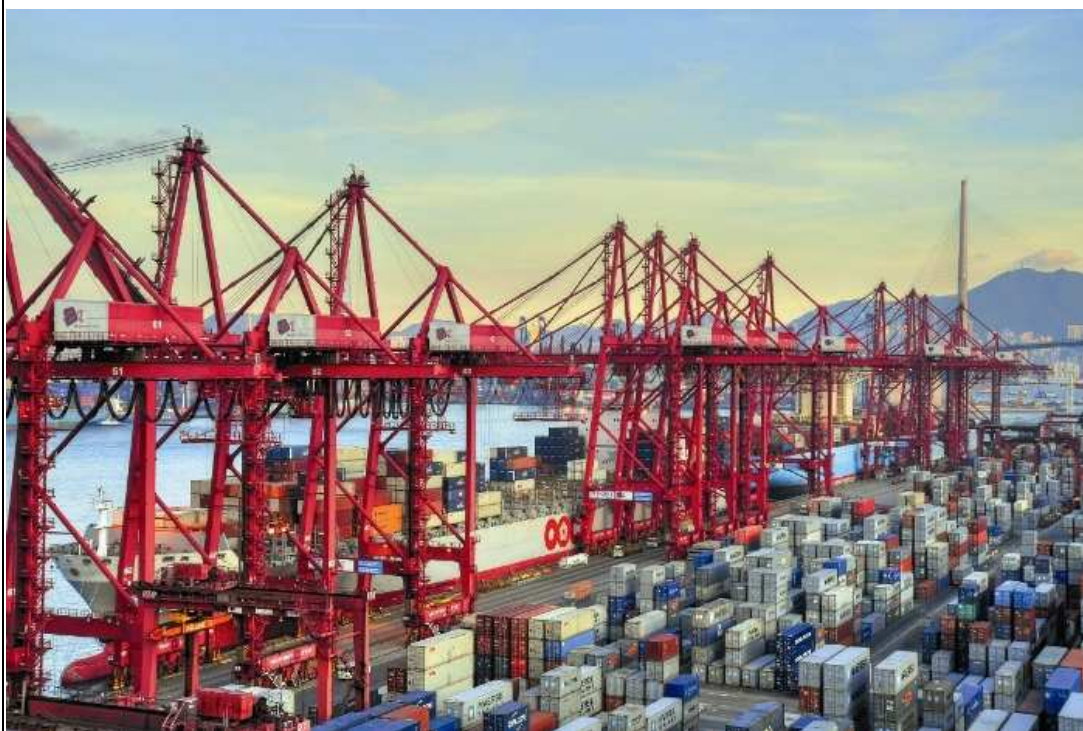
圖 19： MTL 岸邊吊機作業現況
