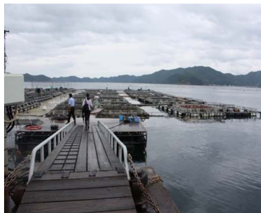
海面箱網養殖區之連通便橋
