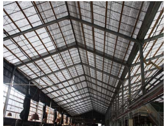
魚苗培育溫室屋頂及側窗部分遮陰
