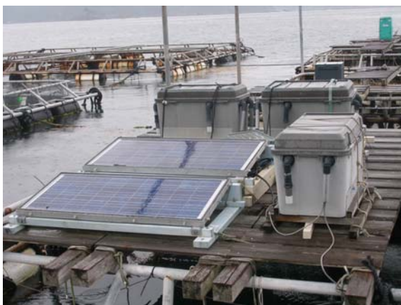
太陽能板及電池提供自動投餌機電源
