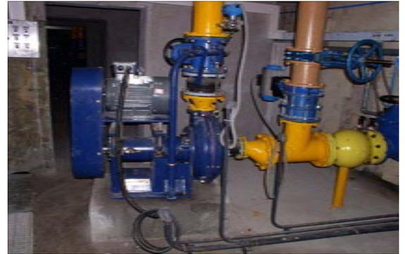
圖4.1-12 微砂存儲及自動投加單元(Hydrocyclone水力旋流器)
