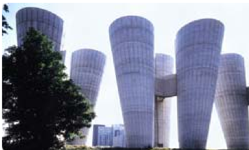
圖 6.2-5 SEDIF 監控管網中配水池
