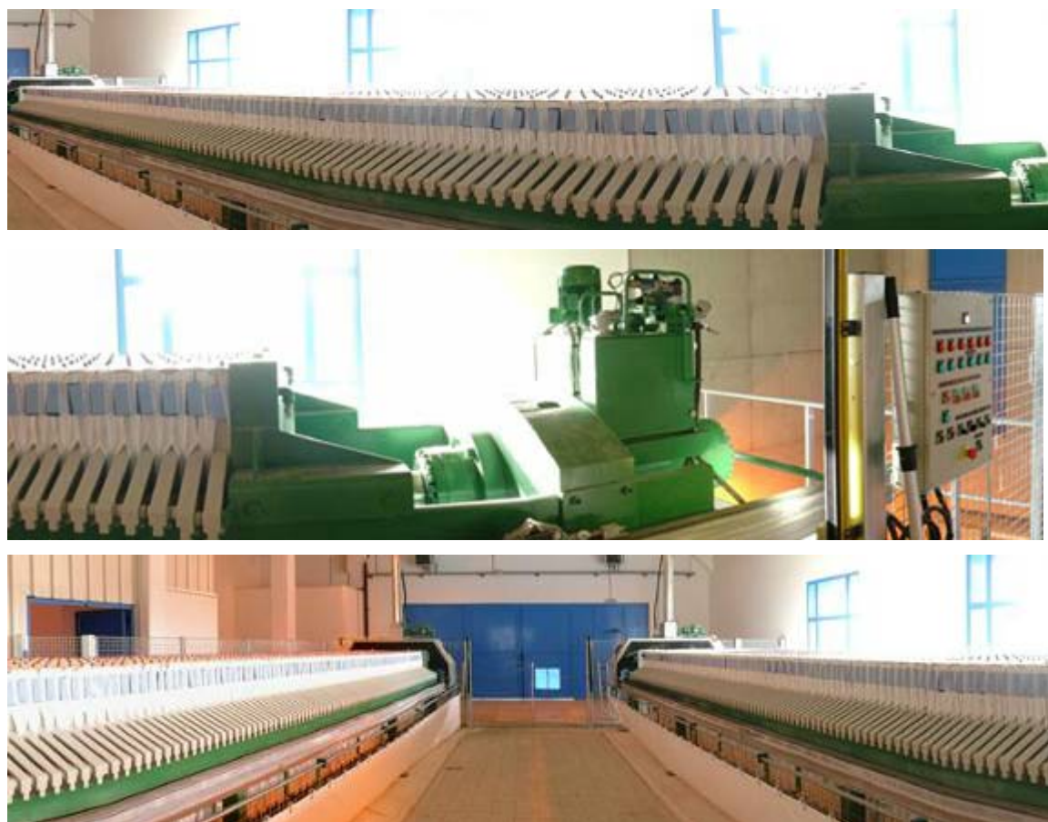
圖 6.1-11 Annet-sur-Marne 淨水場壓濾式機械脫水設備
