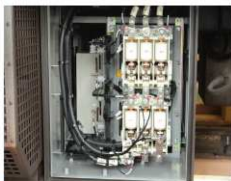
永磁同步電動機 VVVF 控制箱（2）
