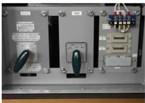
永磁同步電動機 VVVF 控制箱（2）
