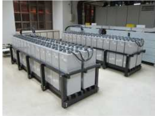
閥調式鉛酸電池 1400AH(600A*1H*24 只) x2 組(79 年建置使用至今已 22 年)
