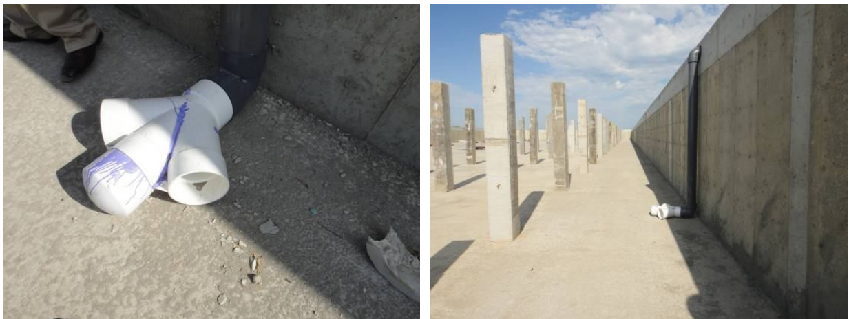
圖 5. 高床下畜糞池及抽取管線
