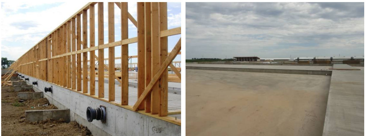
圖 6. 畜舍外糞尿抽取管線及分娩舍地板佈局
