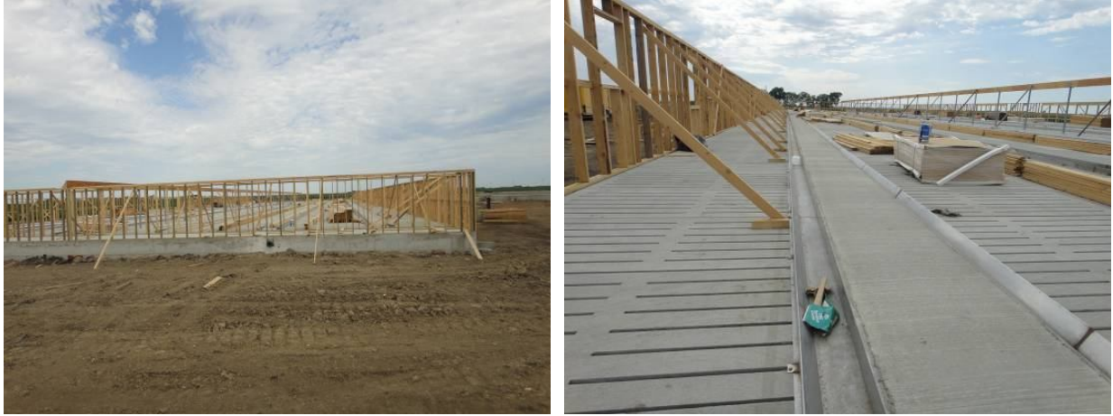
圖 4. 畜舍地板採用水泥條狀高床地板
