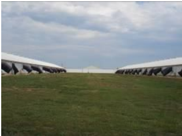
圖 12. 全場排風口之空氣防止逆流裝置
