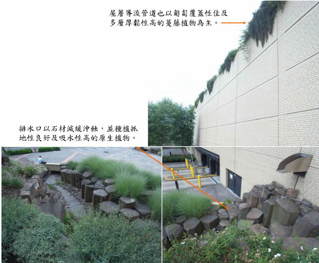
圖 10、波特蘭市會議中心的雨園（The Rain Garden）設計教育解說圖版，利用大面積屋頂匯集，礫石石材。
