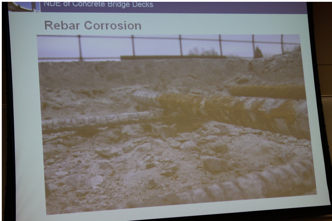
圖 9：橋面板鋼筋鏽蝕(Rebar Corrosion)
