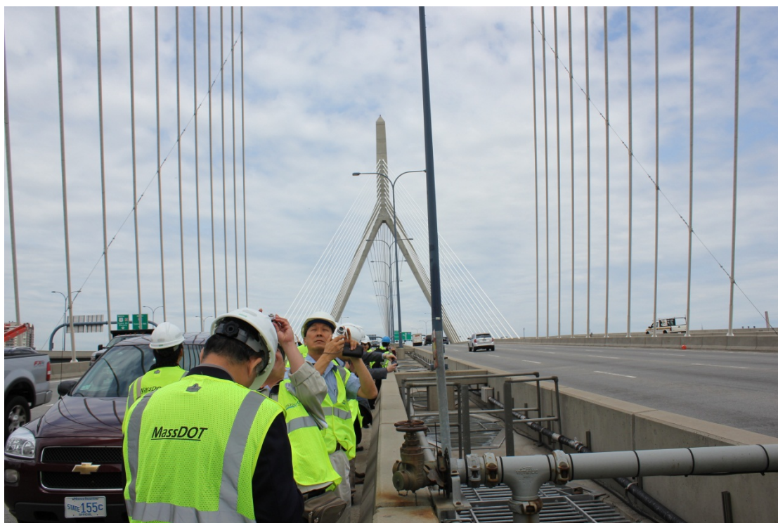
圖 1：橫跨查理士河的 Zakim Bridge，是一座主跨距 745 英尺(約 227 公尺)的雙塔鋼纜橋，美方極有誠意地為我們封閉一車道讓我們參觀。
