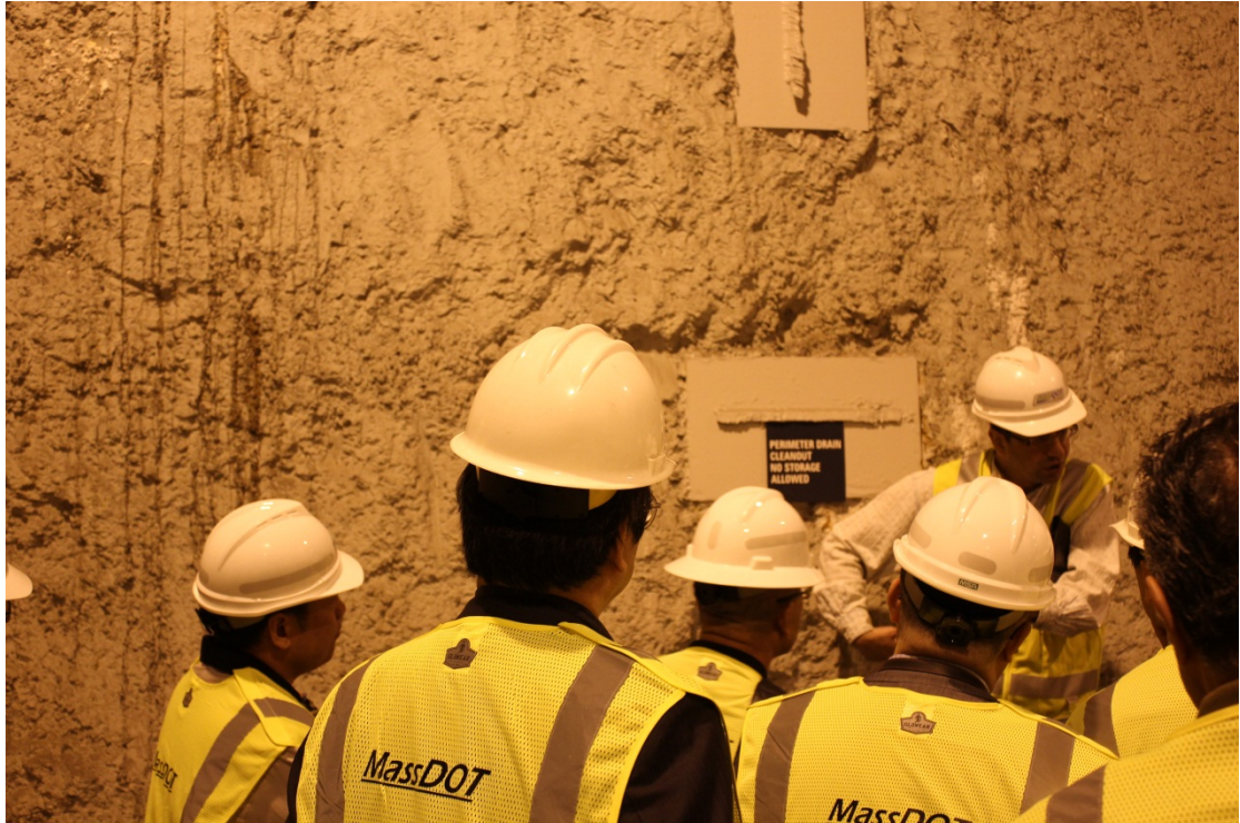
圖 3：美方工程司在向我們解說此深三層樓高機房的開挖過程，背面為連續壁，牆面仍保留混凝土面貌，全無修飾。
