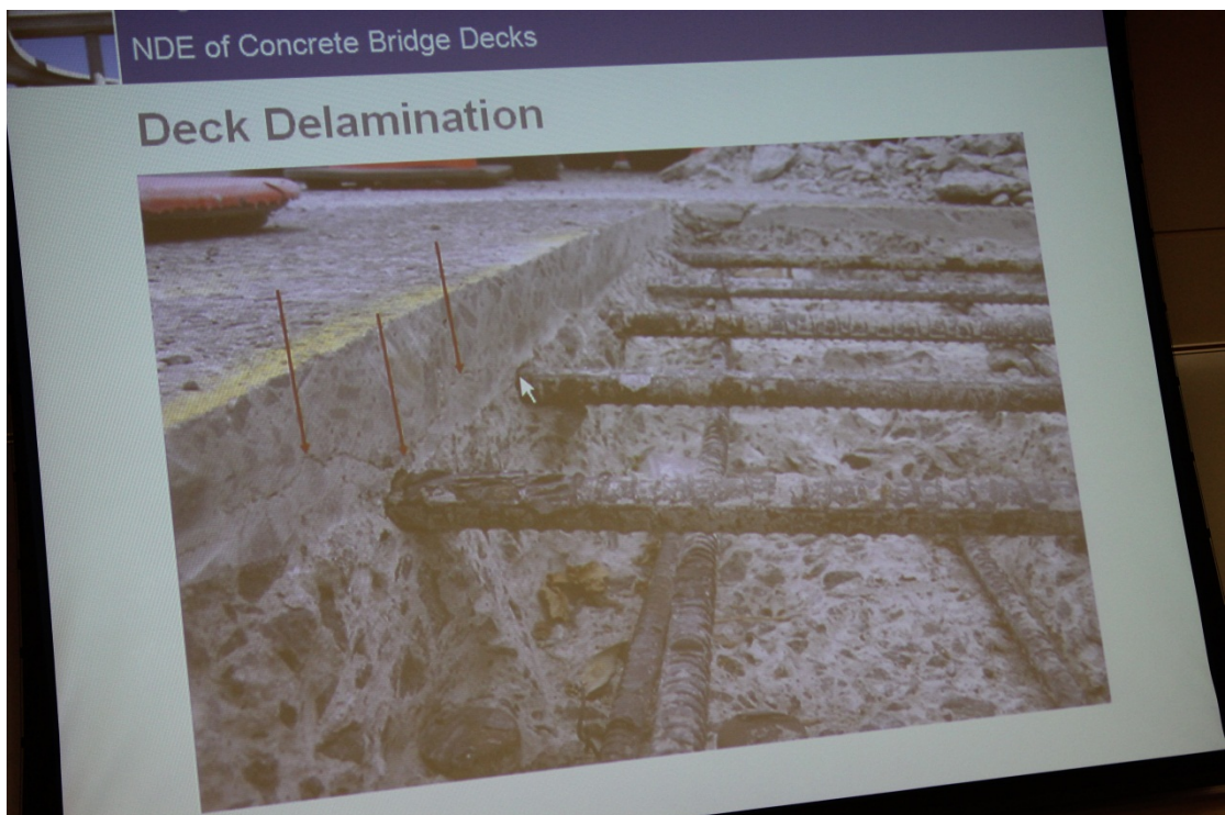
圖 10：因鋼筋鏽蝕造成橋面板混凝土面平行剝離(Deck Delamination)
