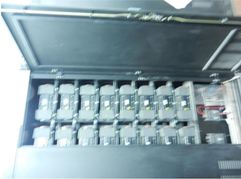
圖 5-11 鋰電池儲能系統
