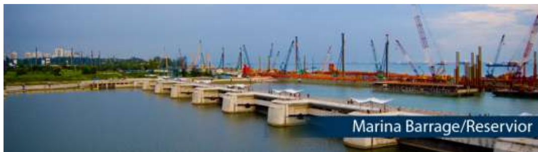
圖 4-3 濱海堤壩照片
