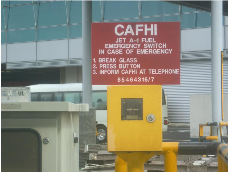
附圖十三：機坪前緊急停油切斷閥
