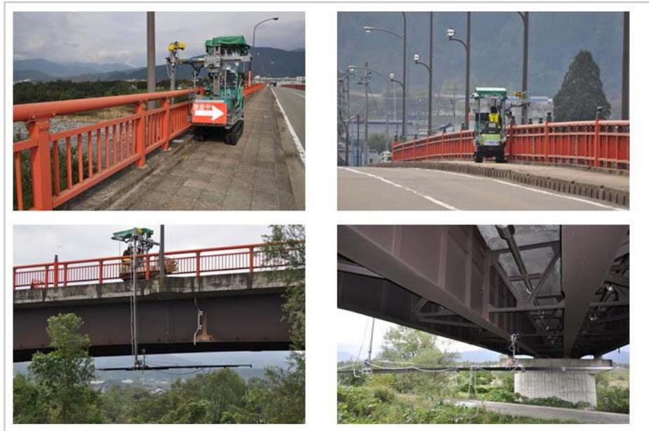
圖 3.15 目視診斷實際作業狀況圖
