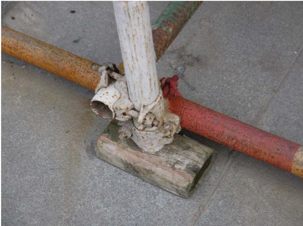
圖 16 單管施工架立架與橫架以制式正交型緊結聯結器固定
