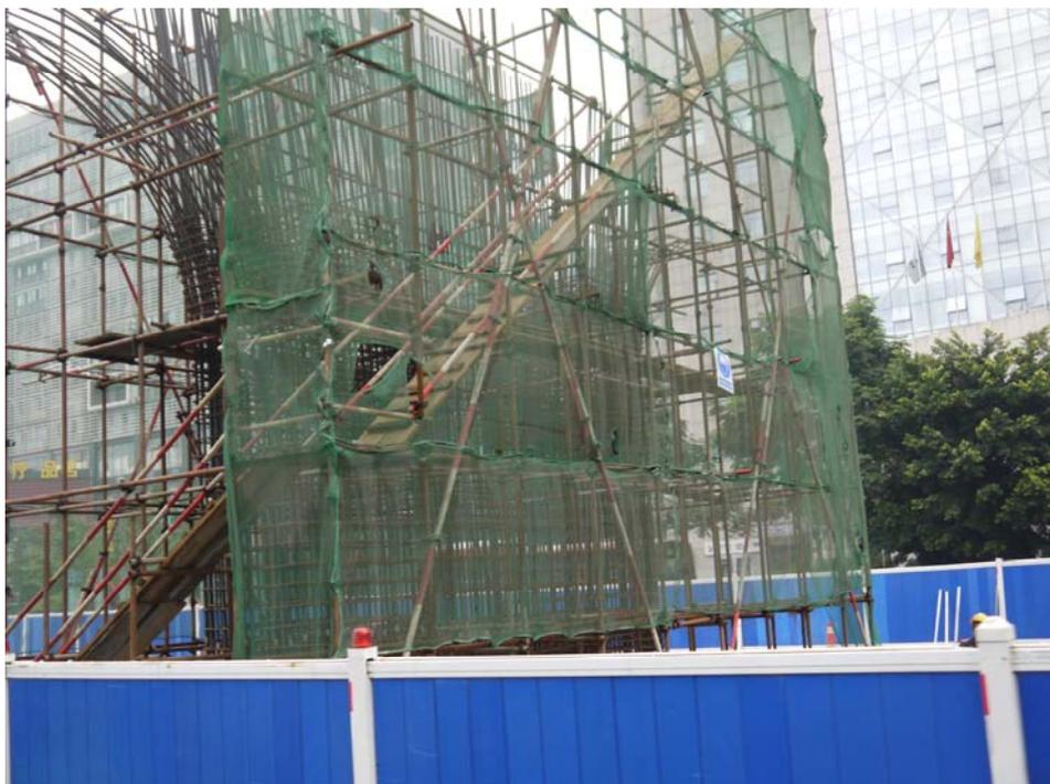
圖 19 柱頭鋼筋綁紮作業之單管施工架及上下設備
