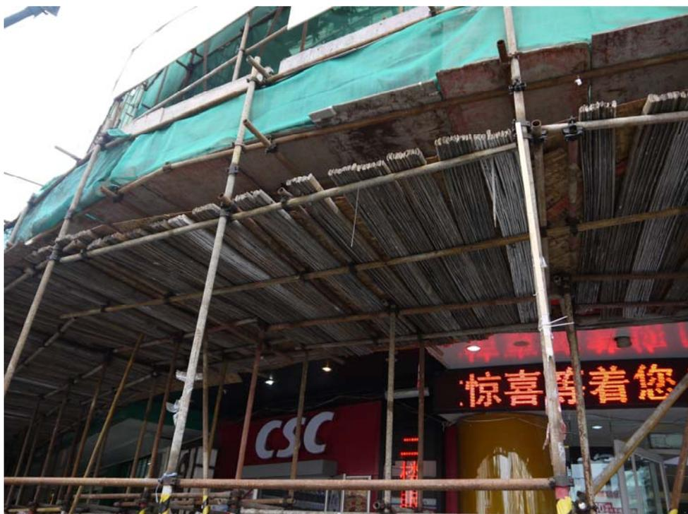
圖 17 單管施工架以竹片做橫架以鋪設工作板料
