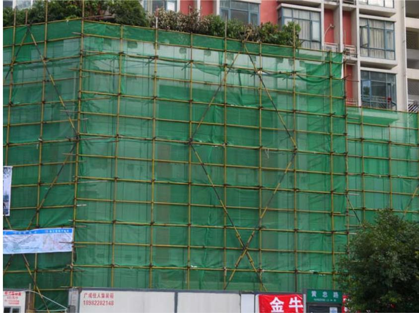
圖 13 成都市區隨處可見外牆整修所搭起的單管式施工架
