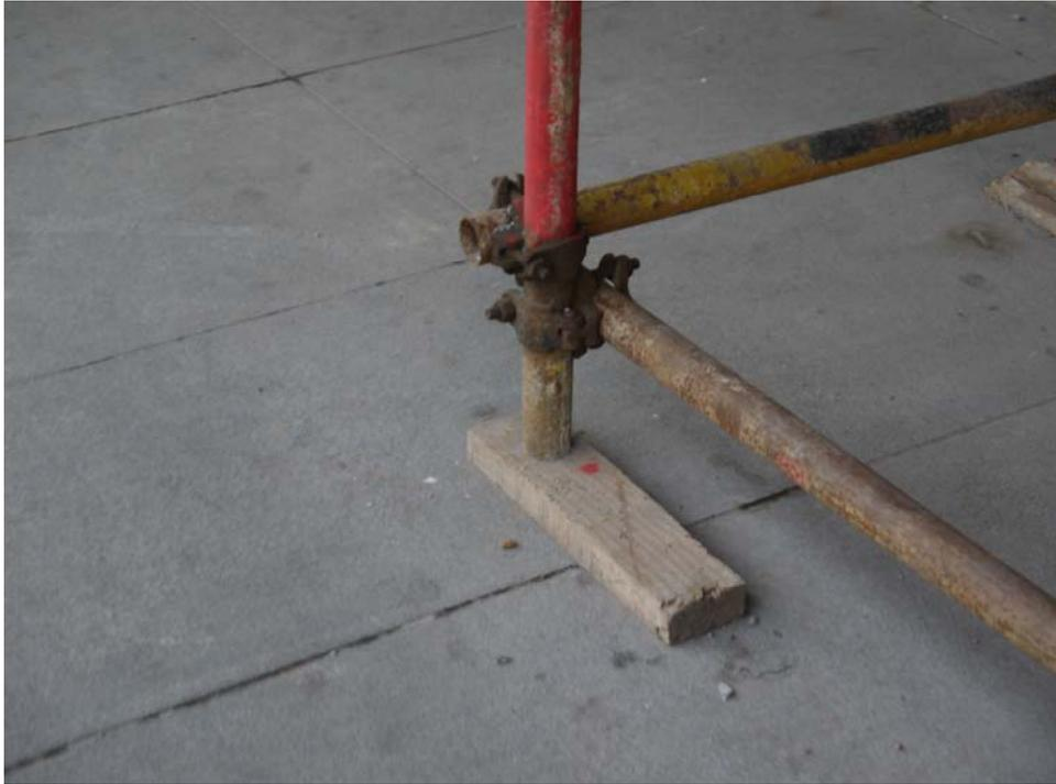
圖 15 單管施工架構件鏽蝕嚴重且立架以木板取代金屬基腳座板
