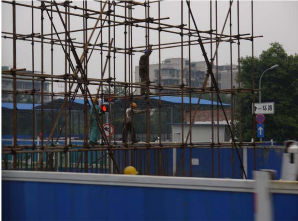
圖 18 單管施工架上未設護欄且工作人員未使用安全帶
